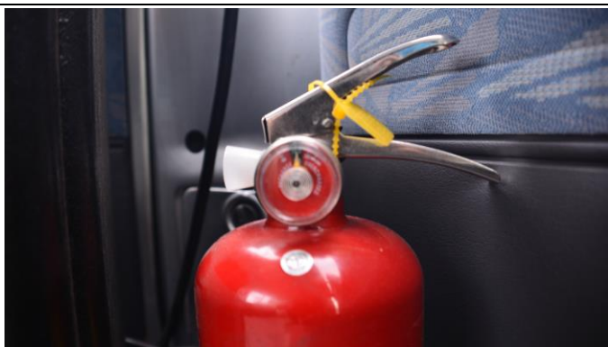
說明：消防器材及設備完善
